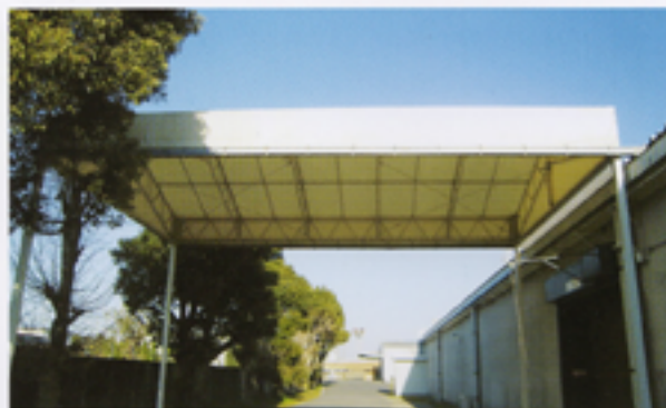
施工例：工場荷捌き場
