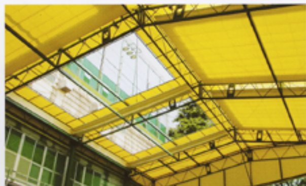
施工例：工場高棚き場
